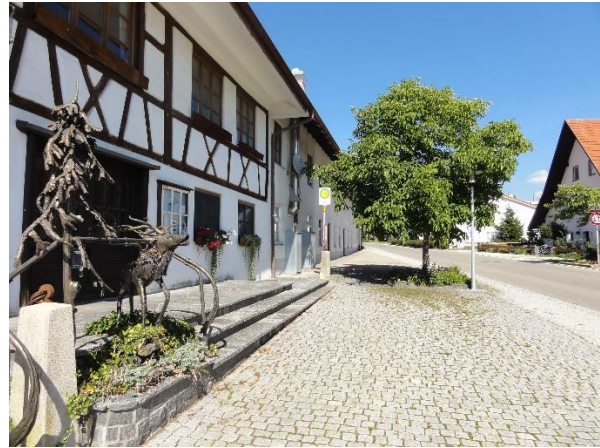
Abbildung 8: Blick von Nordwesten auf die Bestandsgebäude und den Wirtshalder Weg
