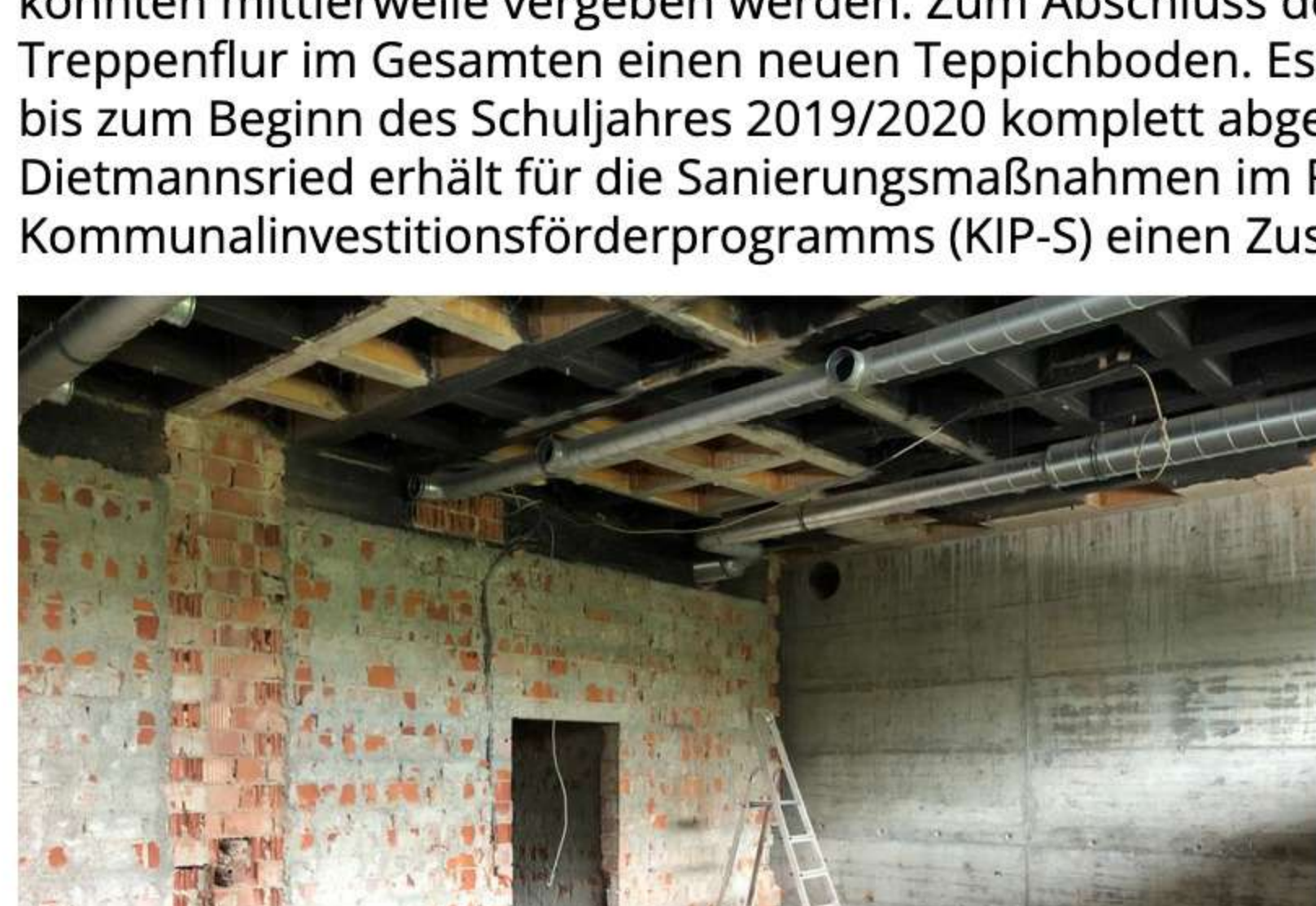
Die WC-Anlage an der Schule sind schon entkernt
