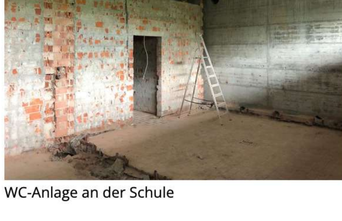
WC-Anlage an der Schule
