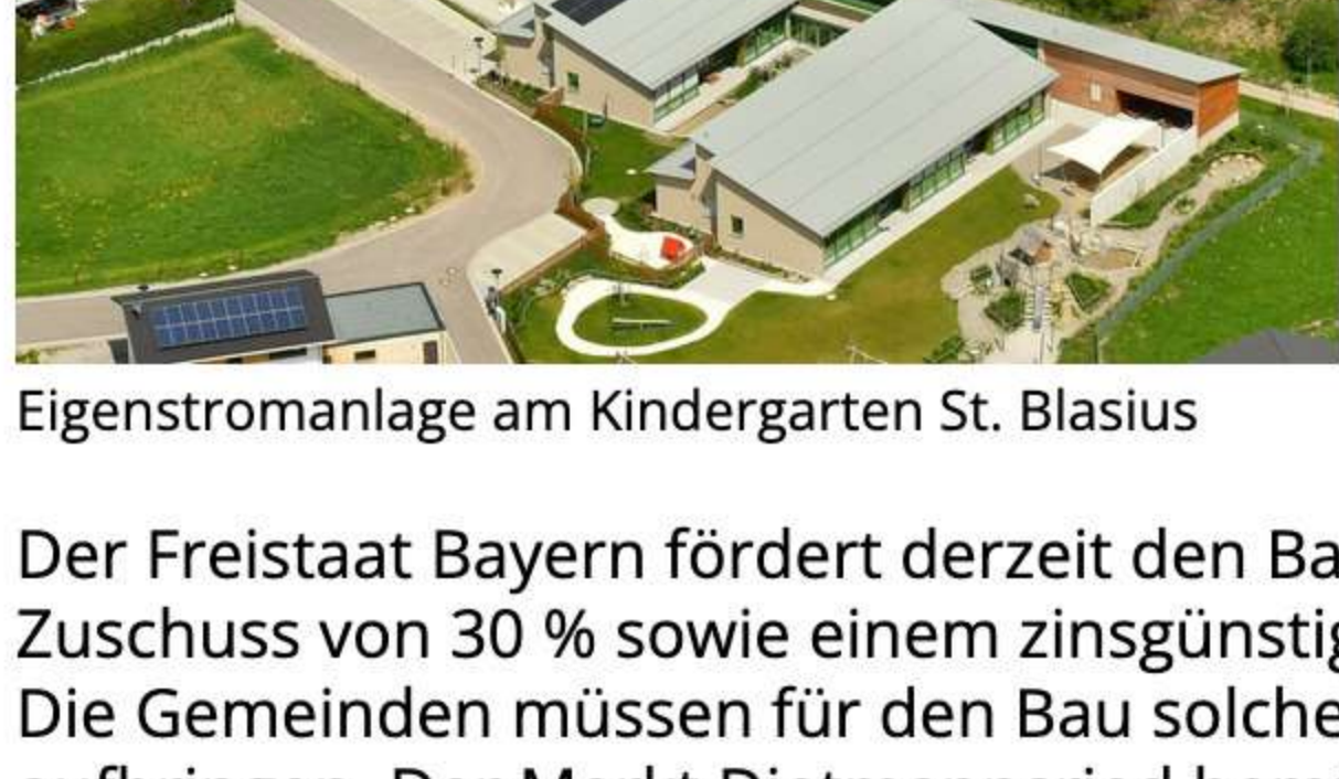
Eigenstromanlage am Kindergarten St. Blasius
