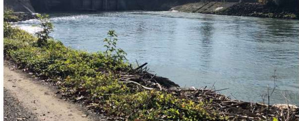
Auch das Wasserkraftwerk Wasserei wurde angefahren
