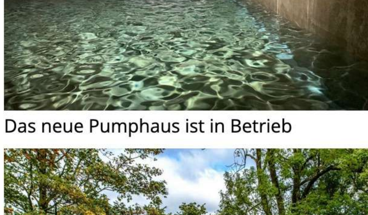
Das neue Pumphaus ist in Betrieb
