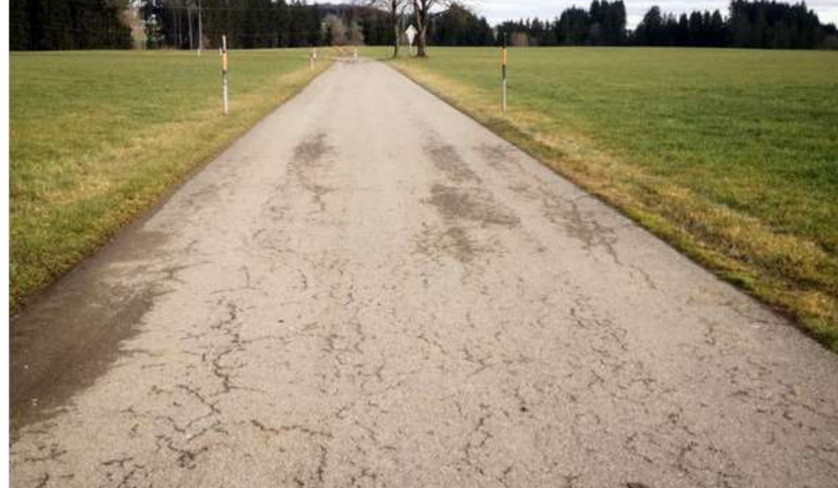
Zahlreiche Straßen werden in 2020 wieder saniert
