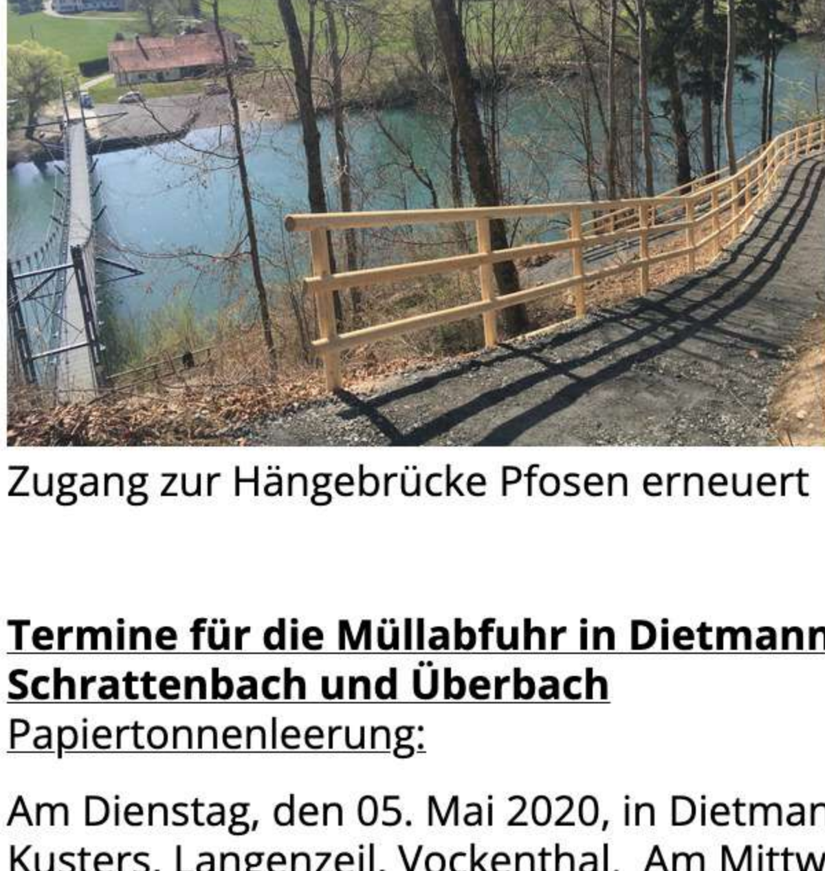
Zugang zur Hängebrücke Pfosen erneuert
