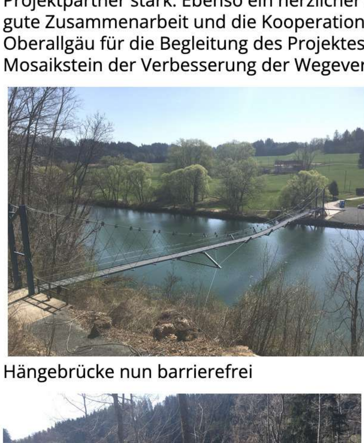
Hängebrücke nun barrierefrei
