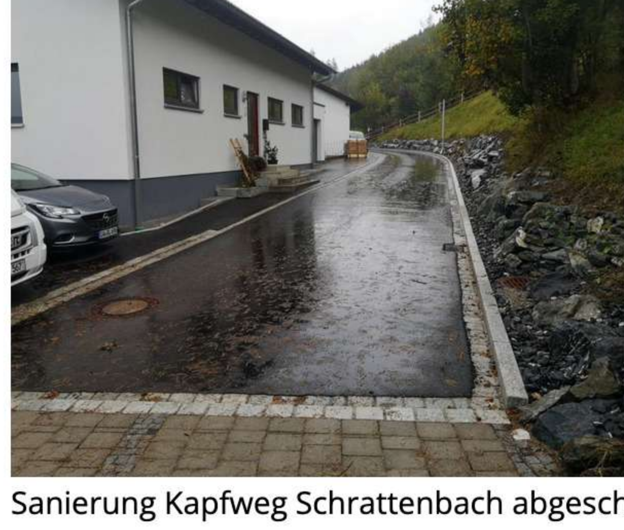
Sanierung Kapfweg Schratzenbach abgeschlossen
