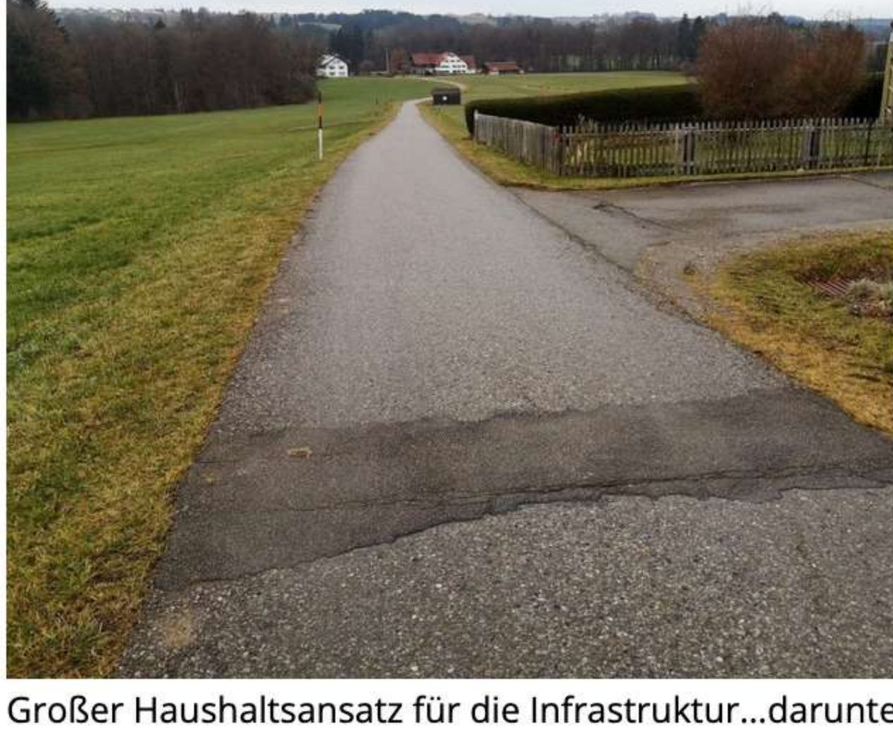
Großer Haushaltsansatz für die Infrastruktur...darunter auch die Straßensanierung Reicholzried - Ried
