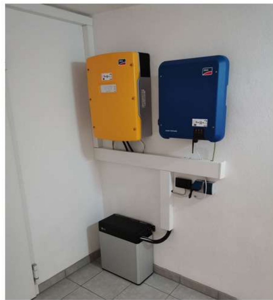
Installation der Steuerung und des Batteriespeichers im Dorfgemeinschaftshaus abgeschlossen
