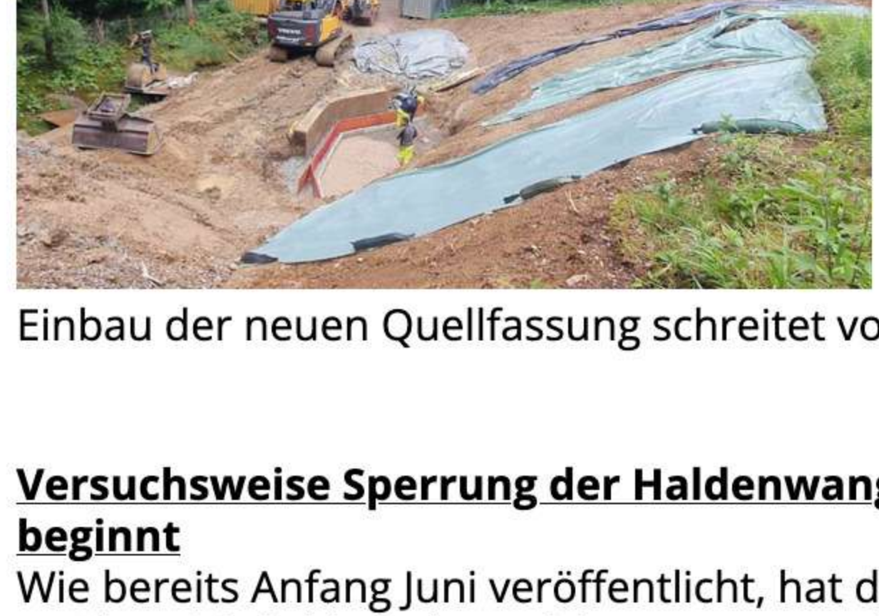
Einbau der neuen Quellfassung schreitet voran
