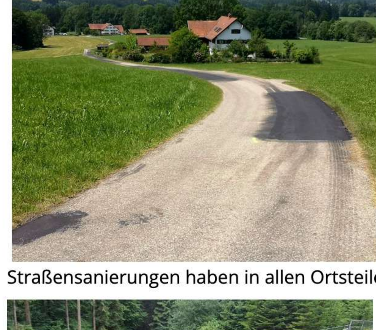
Straßensanierungen haben in allen Ortsteilen begonnen
