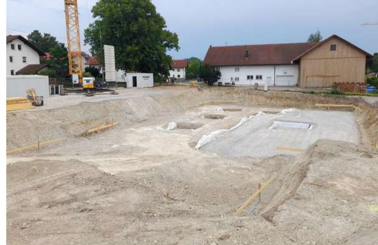
Mit dem Bau der Wohnanlage in Überbach wurde begonnen
