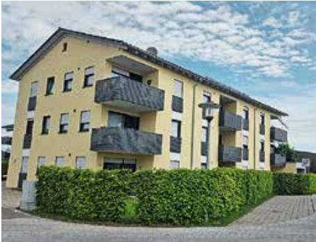
Neubau Wohnanlage Konebergstraße
