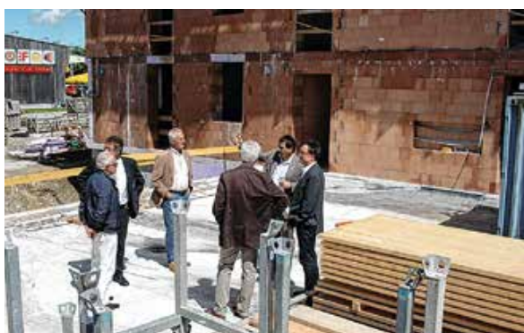
Der Stiftungsvorstand auf der Baustelle Wohnanlage Konebergstraße
