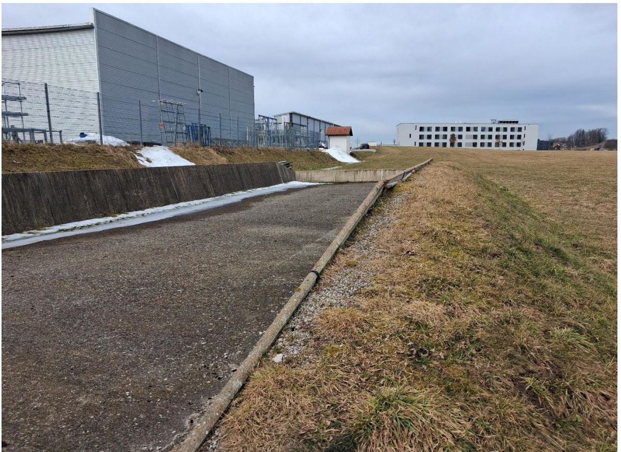
Abbildung 4: Fahrsilo mit umgebender Böschung – Blick nach Westen
