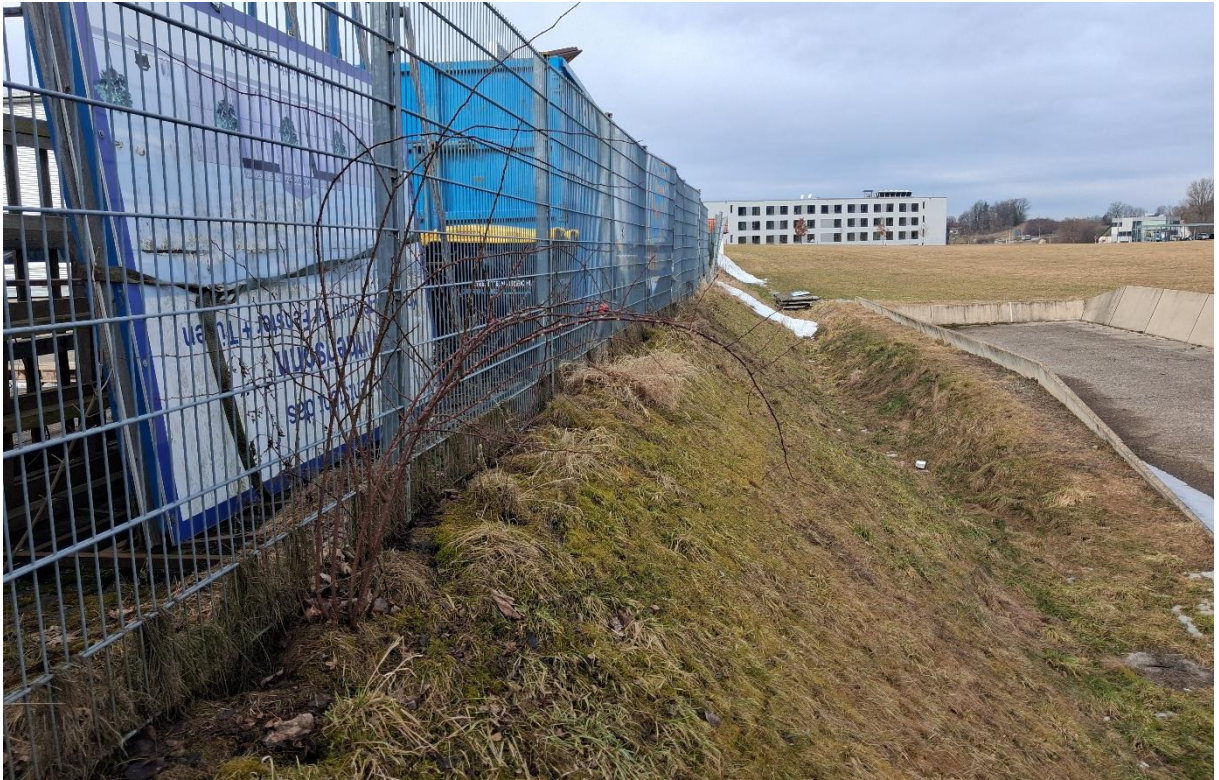
Abbildung 5: Böschung angrenzend zum bestehenden Firmengelände und Fahrsilo - Blick nach Nordwesten
