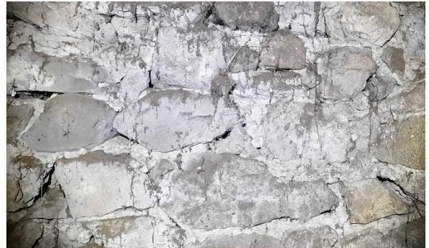
Abbildung 10: Natursteinmauer mit zahlreichen Spalten
